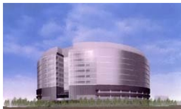
Internet Data Center
